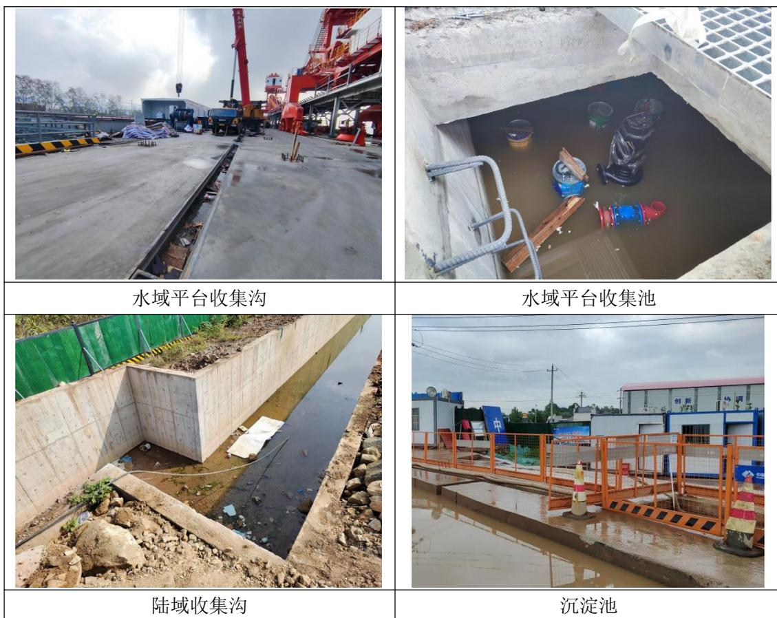
图 6.2-4 项目施工期废水污染防治图
