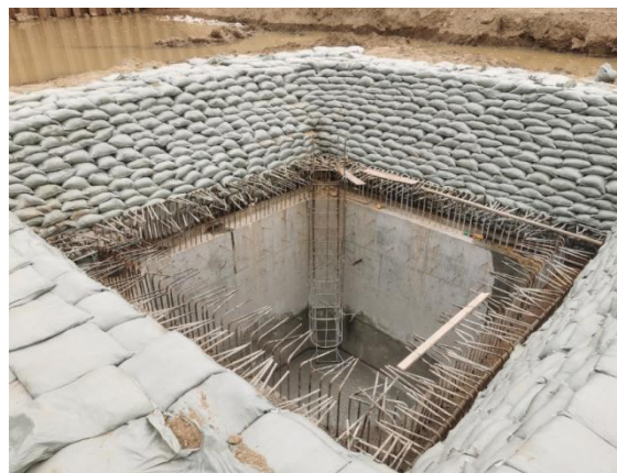
顶管水井施工
