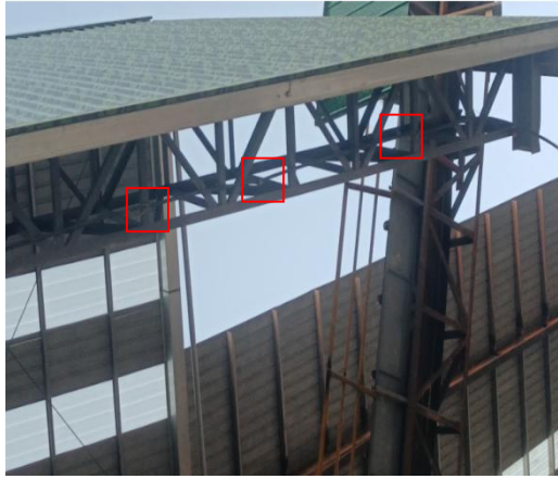
车间门口自动喷雾降尘设施
