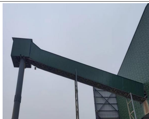
室外传送带封闭
