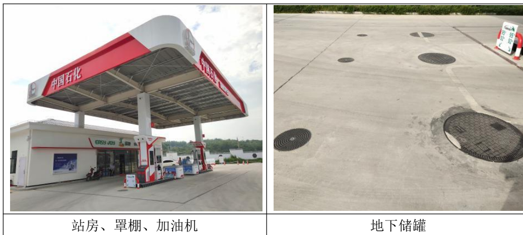
图 2-1 项目现场情况图片
